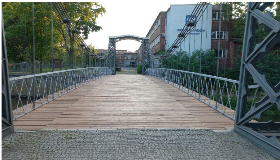
Fot. Wymiana dyliny na Zabytkowym Moście w Ozimku.
