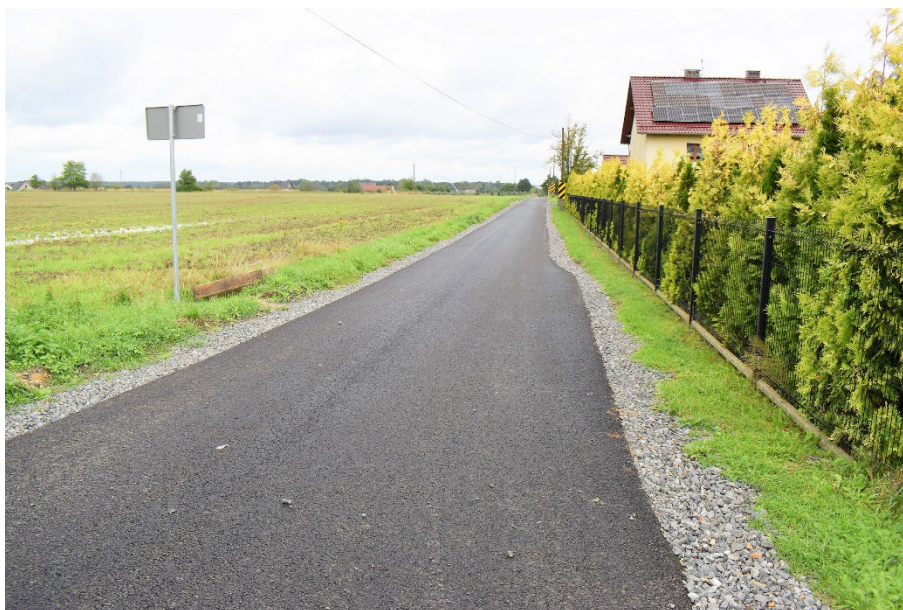
Fot. Budowa drogi dojazdowej do gruntów rolnych we wsi Pustków, obręb nr 0130 Szczedrzyk arkusz 2, działka nr 343, jednostka ewidencyjna Ozimek.
