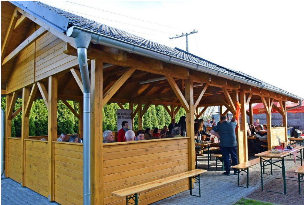
Fot. Budowa wiaty wolnostojącej wraz z wykonaniem podłoża z kostki brukowej – Fundusz Sołecki Schodnia.
