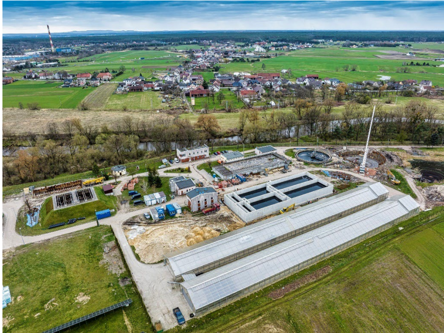
Fot. Modernizacja oczyszczalni ścieków w Antoniowie.
