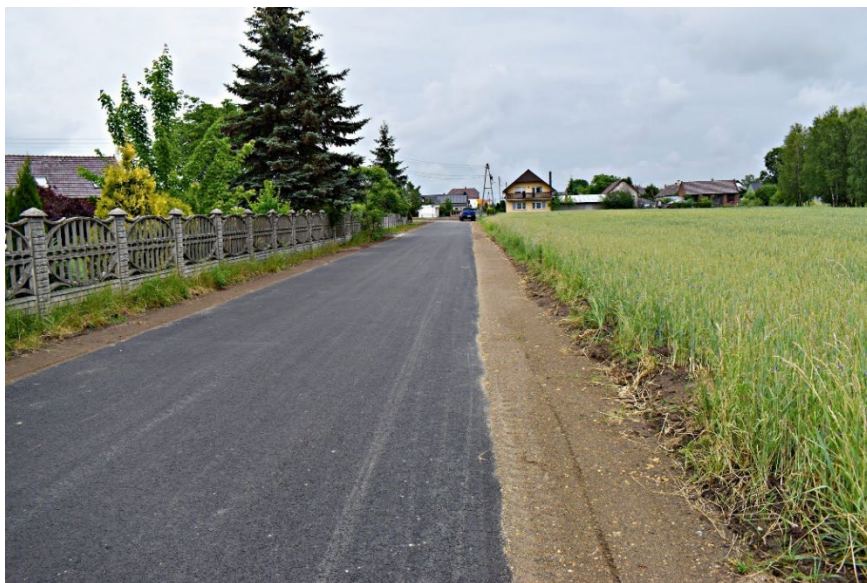
Fot. Przebudowa drogi gminnej wewnętrznej - ul. Niweckiej w m. Szczedrzyk.
