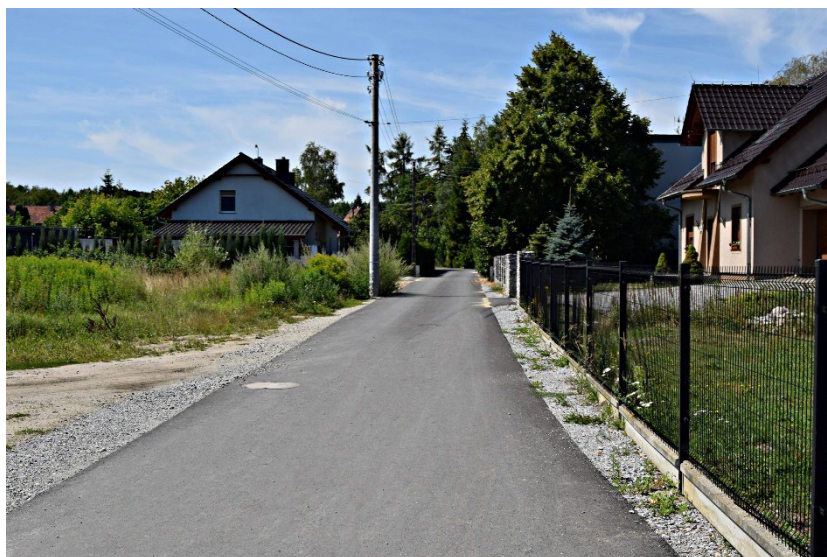
Fot. Modernizacja dróg ul. Waryńskiego i Jelenia w m. Ozimek.
