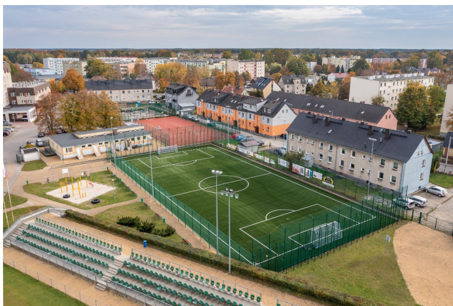
Fot. Remont nawierzchni sztucznego boiska trawiastego na kompleksie boisk Orlik w Ozimku.
