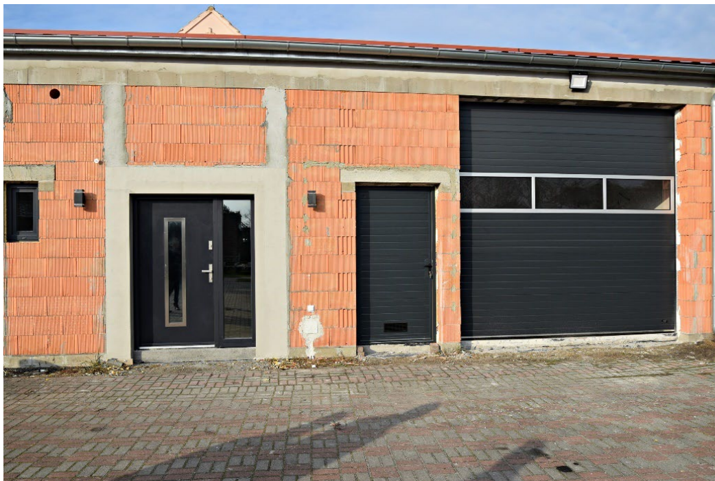
Fot. Budowa remizy OSP w Antoniowie.
