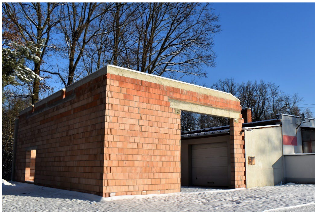
Fot. Budowa remizy OSP w Krasiejowie.
