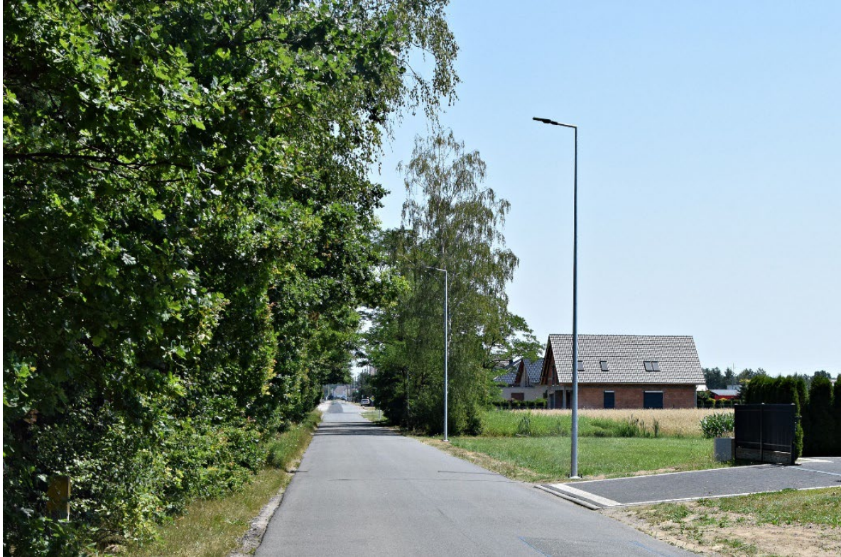
Fot. Budowa punktów oświetlenia ulicznego z infrastrukturą techniczną (m. Krasiejów).
