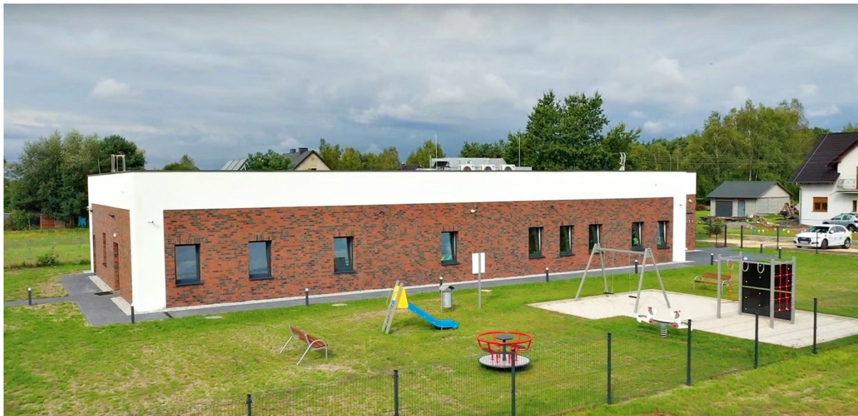
Fot. Budowa Przedszkola w Groźcu.
