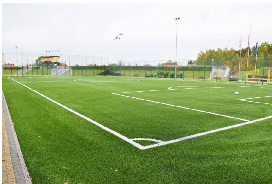
Fot. Nowa nawierzchnia sztucznego boiska trawiastego.
