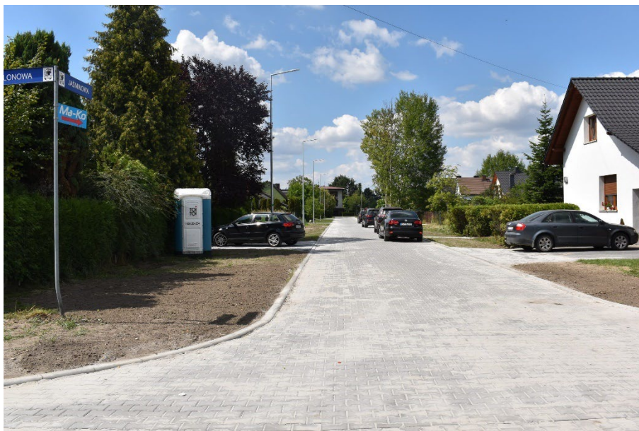
Fot. Przebudowa drogi gminnej ul. Jaśminowej w m. Antoniów.
