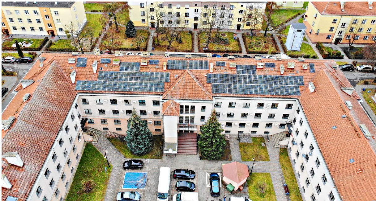
Fot. Budowa instalacji fotowoltaicznej oraz montaż klimatyzacji w budynku Urzędu Gminy i Miasta w Ozimku
