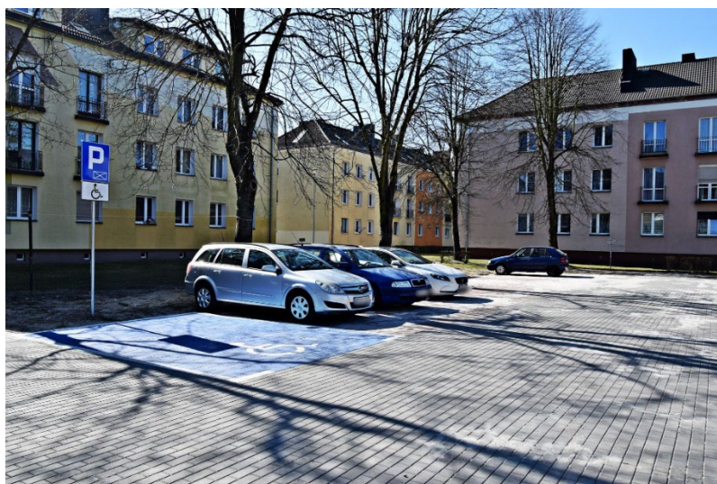
Fot. Budowa miejsc parkingowych oraz miejsc utwardzonych przy ulicy Lipowej.
